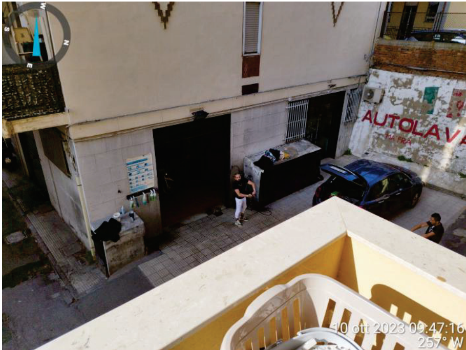
Foto3 – Vista dal balcone della II elevazione f.t. dell’immobile RS verso l’area dell’attività di autolavaggio
